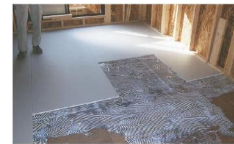
▲タイガースーパーハードの張り方、接着材の塗布
